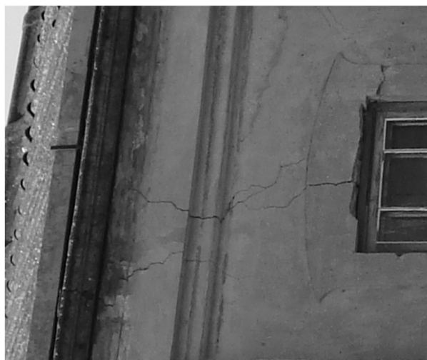
Exemplo de rachadura em alvenaria da Vila Belga
